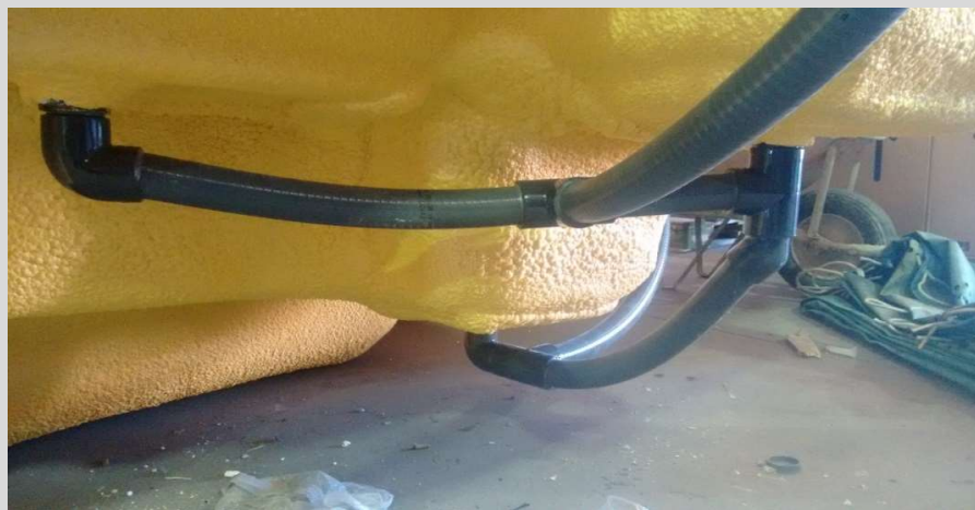
Ilustración 5. Conexión tubo 50mm a la piscina
