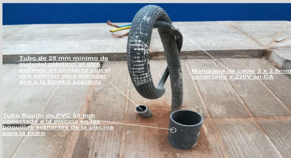
Ilustración 3. Preinstalación para Borealbox
