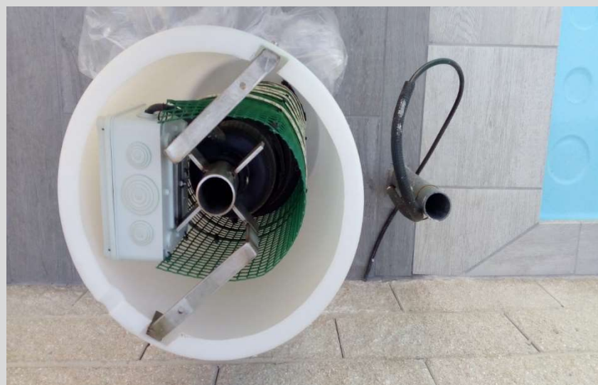
Ilustración 7. Sacar interior del dispositivo
