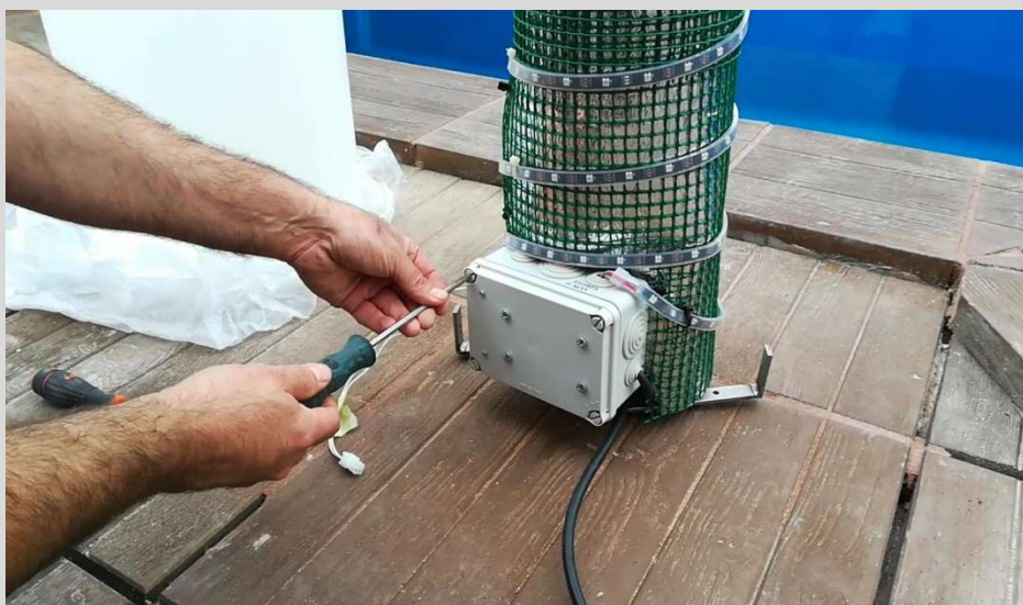
Ilustración 9. Abrir caja de conexiones
