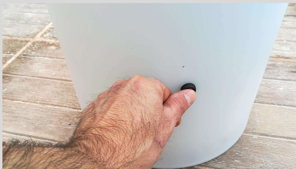
Ilustración 2. Estado Manual ON/OFF para la bomba soplante
